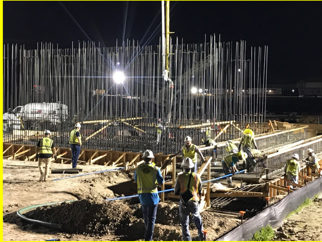
Night-time Concrete Pour
